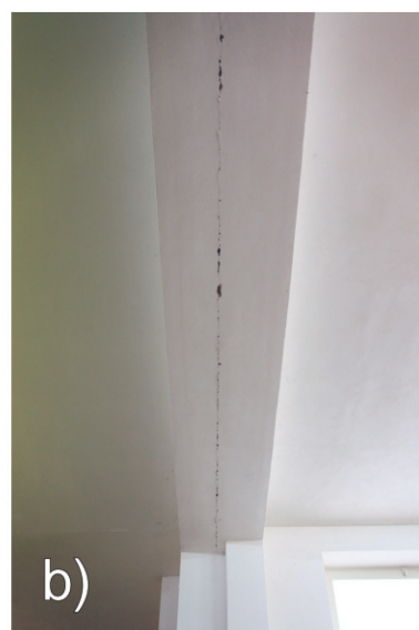
Foto 10 a) Giarratana: crollo parziale di un muro perimetrale “a sacco” di un vecchio edificio abbandonato (cl. A), alle spalle della chiesa madre; b) San Giacomo: lesione e distacco tra le travi di un edificio in c.a. (cl. C) adibito a capannone commerciale.
