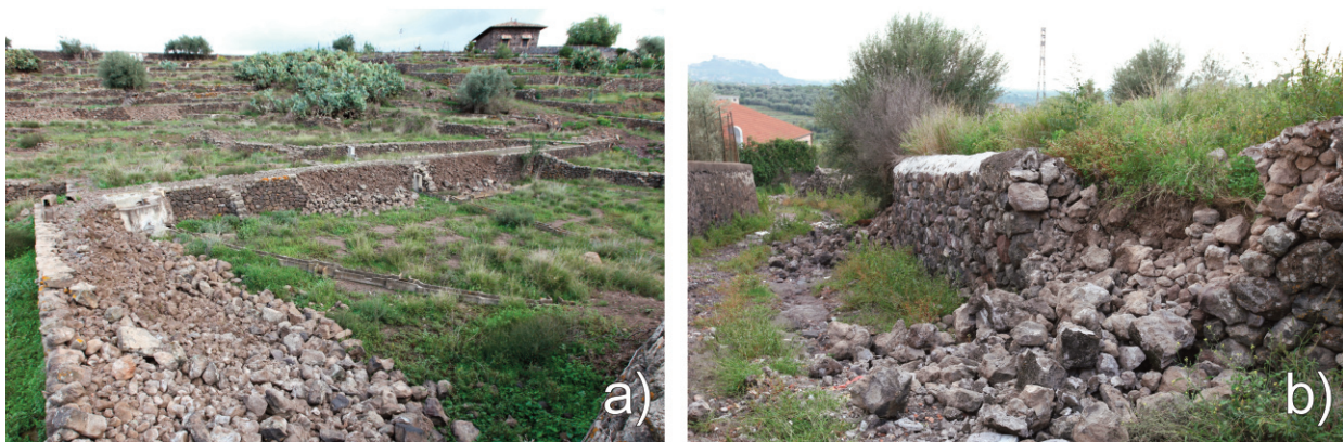
Foto 4 C.da Mendolito (S. Maria di Licodia): a) la maggior parte dei muri di contenimento dei terrazzamenti appaiono franati; b) diffusi i crolli dei muretti a secco delimitanti strade e proprietà.
