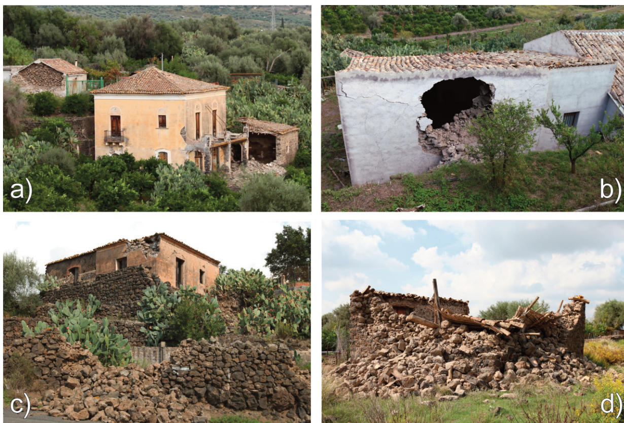
Foto 3 C.da Mendolito (S. Maria di Licodia): a) crollo della balconata ed altri danni sostanziali in un edificio in muratura (cl. B), a fianco e sullo sfondo crolli parziali di edifici in muratura "a sacco" (cl. A); b) rottura muraria per espulsione dei blocchi in un vecchio edificio ristrutturato (cl. A); c) rottura dell'angolata muraria per l'azione spingente del tetto, in primo piano crollo di un muro a secco; d) crollo totale di un edificio rurale in stato di degrado.
