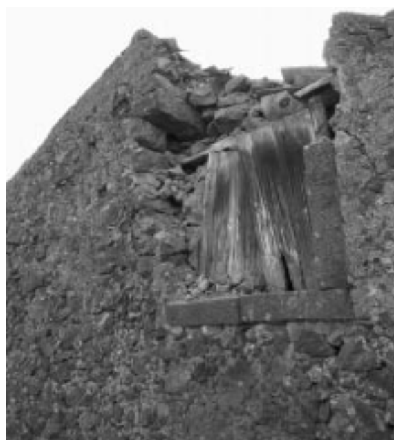
Foto 1.2 Primoti: crollo parziale di un edificio rurale (cl. A).
