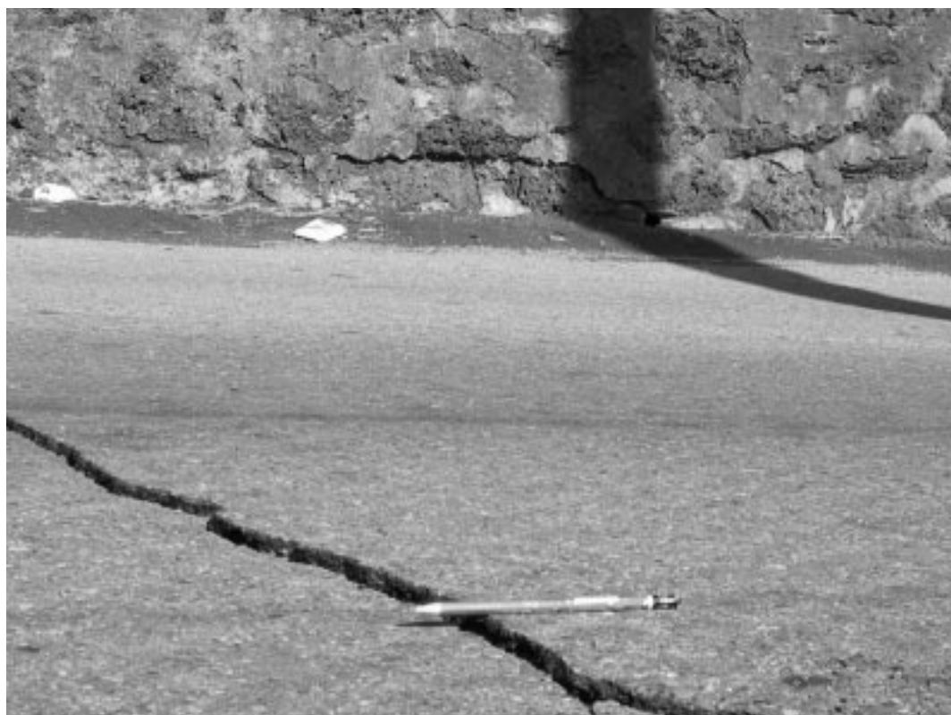
Foto 1.9a Effetti di fagliazione superficiale cosismica lungo la faglia S. Tecla. Località S. Tecla, strada provinciale SP 2/I°; b) località Mortari.
