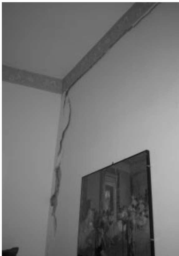
Foto 1.7 S. Maria Ammalati: distacco del prospetto principale di un edificio in muratura di classe B (dichiarato inagibile).
