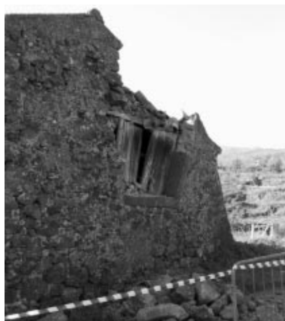
Foto 1.2 Primoti: crollo parziale di un edificio rurale (cl. A).
